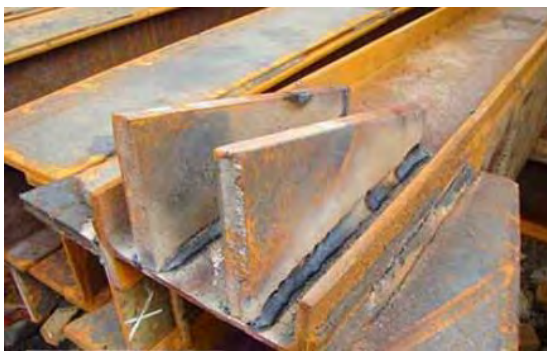
ب) شکل ۳-۱۹ اتصال سازه فلزی جوش کاری
