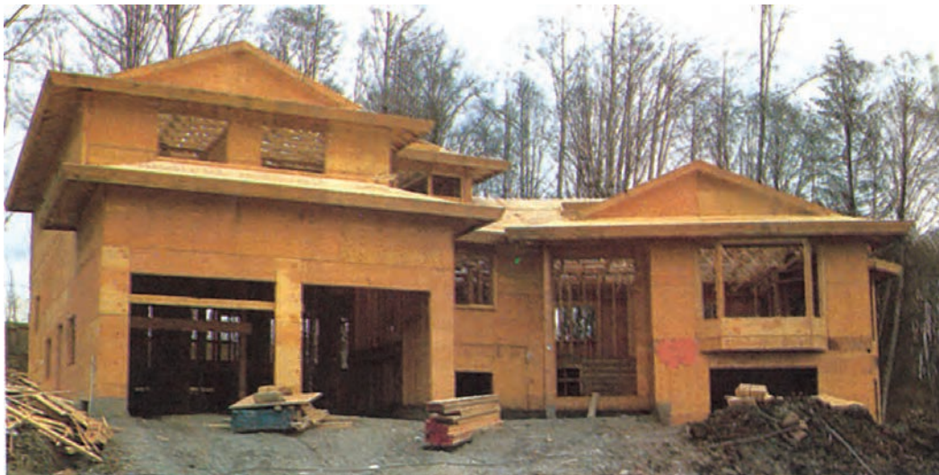
شکل ۶۳-۲- مورد مصرف تخته چند لایه در کارهای ساختمانی
