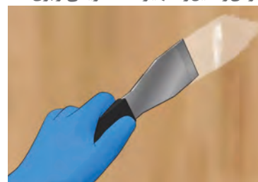
۴- صاف کردن هرگونه ترک از روی دیوار
