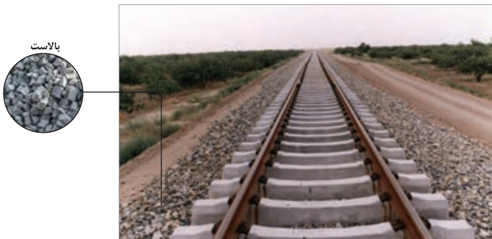
شکل ۱۱-۴. بالاست در زیرسازی جاده ریلی
