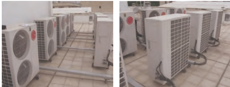
عدم رعایت فاصله مناسب - عدم چینش صحیح
