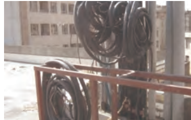
عدم نصب صحیح لوله‌ها (لوله کشی)
