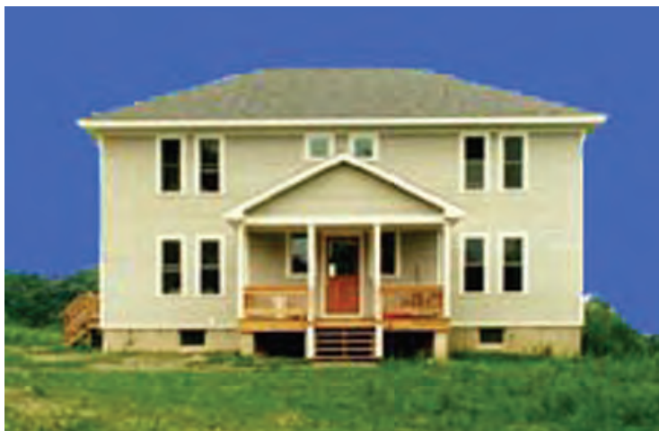
شکل ۱۶-۱- نمای ساختمان اجرا شده
