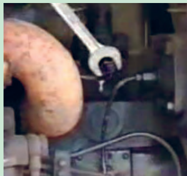
شکل ۲۹. شل کردن مهره لوله پر فشار انژکتور
