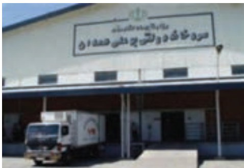
شکل ۲-۶- سردخانه بوعلی - همدان
