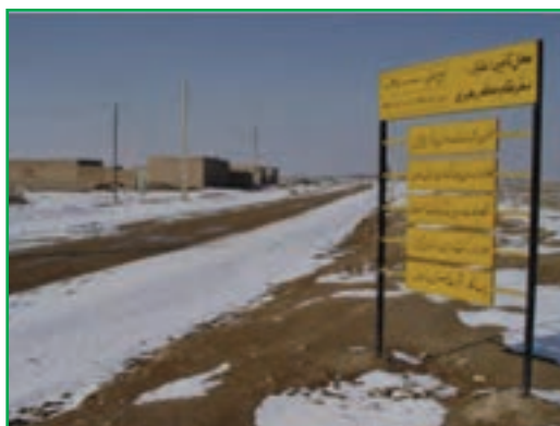
شکل ۶-۶- پروژه احداث راه روستایی - آق تپه
