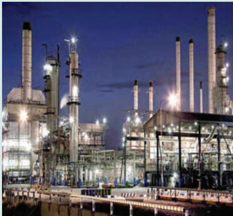
شکل ۵-۶- نیروگاه برق در تهران
