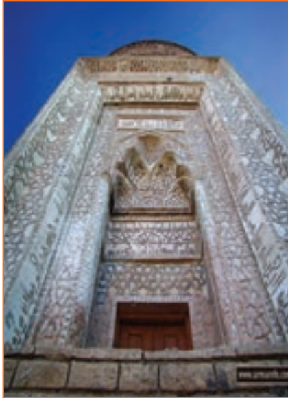
شکل ۲۴-۴- نمایی از سه گنبد ارومیه
