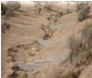
شکل ۱-۶۳- بند گابیونی (سنگ ها در تور سیمی)
