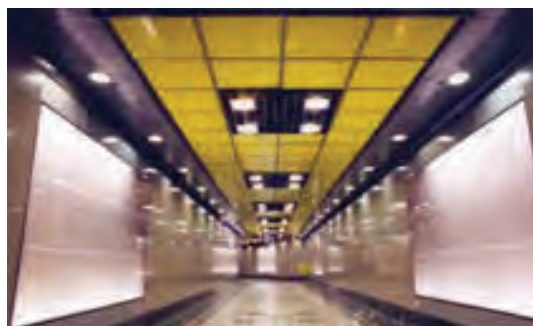
سقف کاذب تایل آلومینیومی با شبکه فلزی
