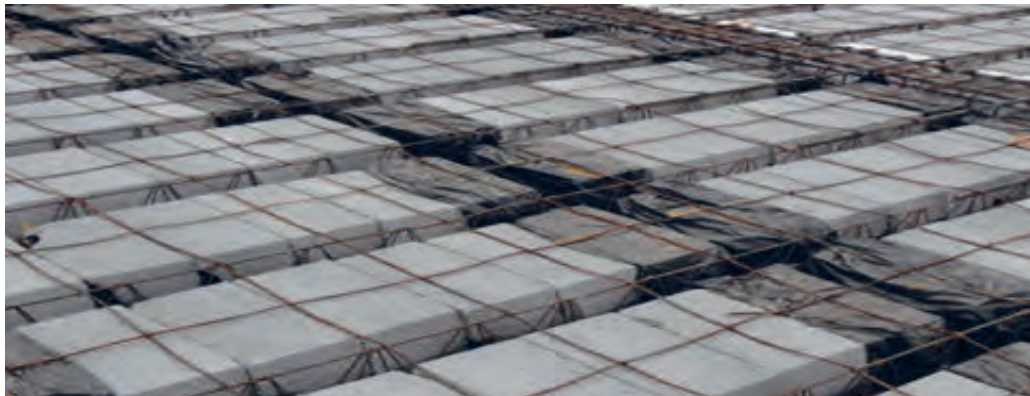
اجرای شناژ مخفی در سقف تیرچه بلوک
