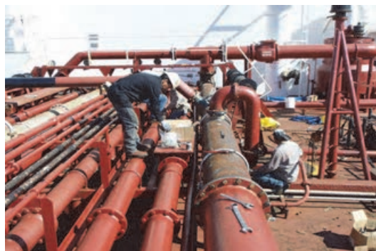
شکل ۷- در حال اجرای لوله‌کشی کشتی
