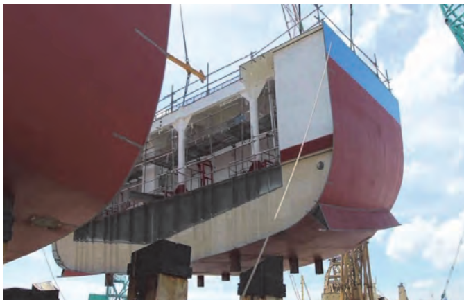
شکل ۸- اتصال بلوک‌های کشتی
