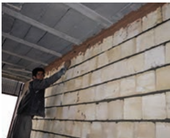
شکل ۲-۴- اجرای دیوار چینی با بلوک سفالی
