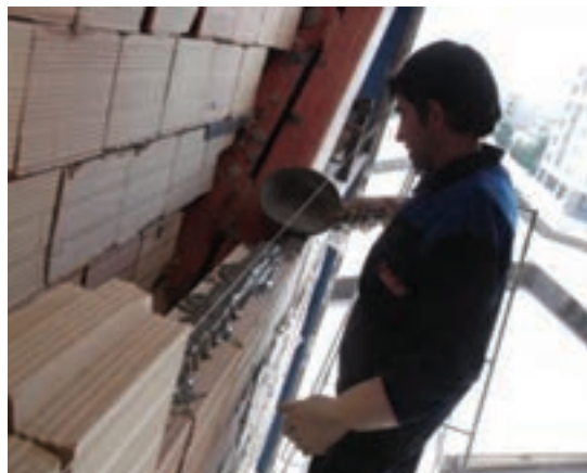
شکل ۴-۶- ملات ماسه سیمان جهت اتصال بلوک‌ها
