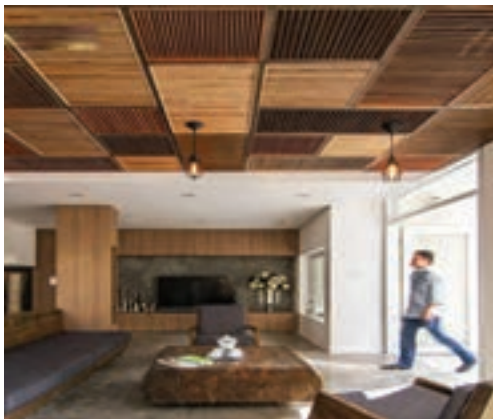
شکل ۲۶-۴- تزئینات سقف کاذب چوبی
