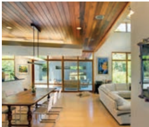
شکل ۲۵-۴- سقف لمبه کوبی شده چوبی
