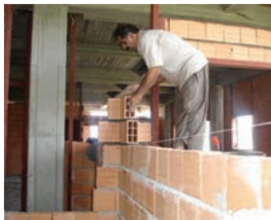
شکل ۱-۴- ریسمان کشی جهت اجرای مستقیم دیوار
