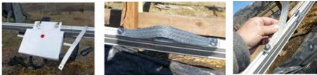
شکل ۲۹- همبندی در سامانه فتوولتاییک
