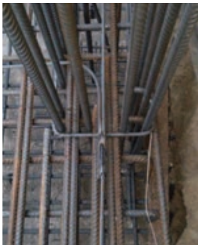
شکل ۲۲- جوشکاری میلگردهای شناژ با شالوده
