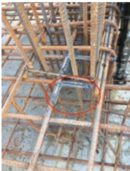
شکل ۱۹- جوشکاری میلگردها در یک تقاطع چهارراه
