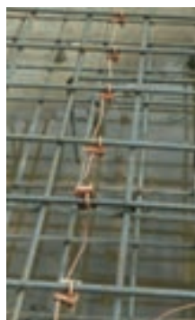
شکل ۱۰- اتصال هادی همبندی مسی به میلگردهای موجود در سازه با استفاده از بست
