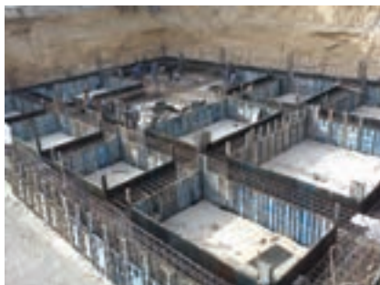
شکل ۵ - قبل از بتن‌ریزی (شالوده)
