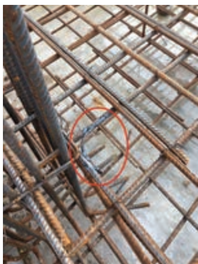
شکل ۲۰- جوشکاری میلگردها در گوشه
