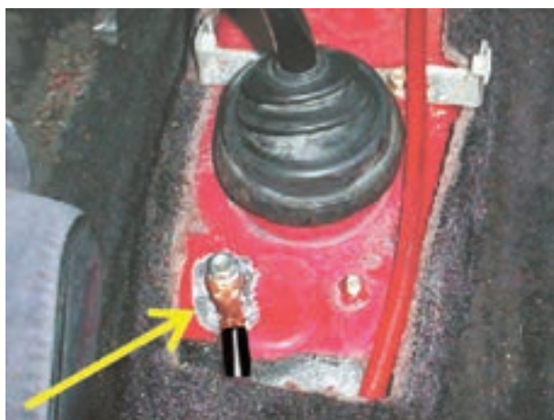
شکل ۲-۲۵- اتصال بدنه‌ی باتری در داخل اتاق خودرو
