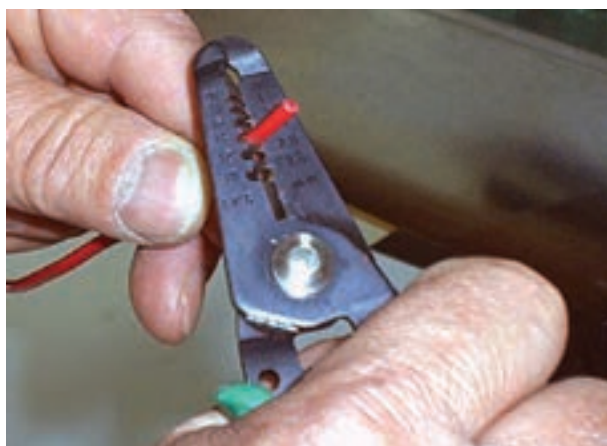
شکل ۴-۶۴- جدا کردن عایق سیم‌ها
