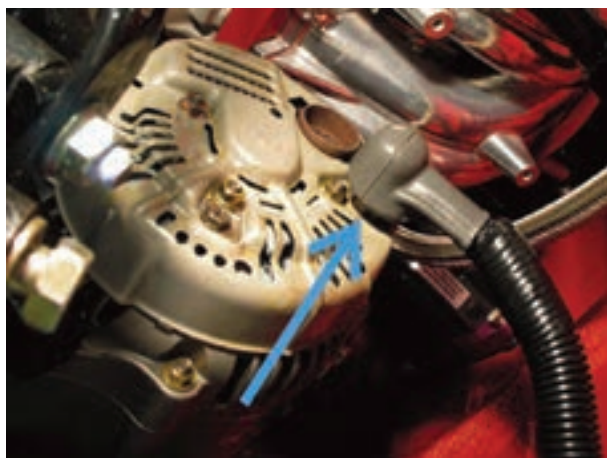
شکل ۲۴-۳- عایق اتصال الکتریکی ترمینال آلترناتور
