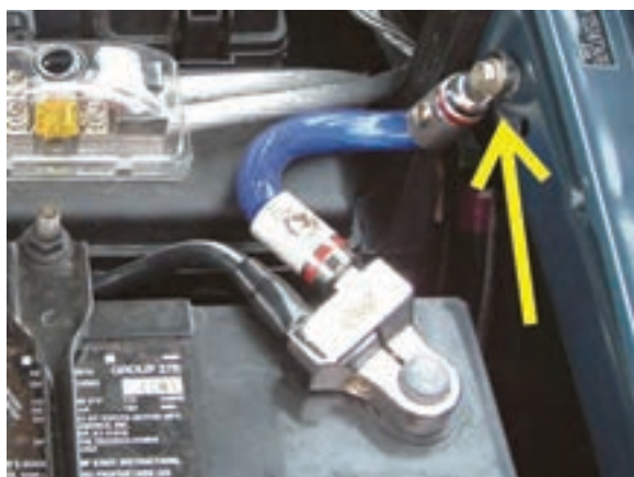
شکل ۲-۲۴ اتصال کابل منفی باتری به بدنه
