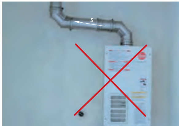
شکل ۱-۳۶ اتصال نادرست دودکش
