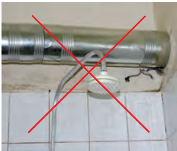
شکل ۳-۱۱ عبور غیر مجاز دودکش
