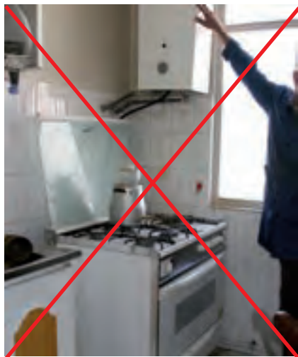
شکل ۱-۶ نصب نادرست آب گرم کن.
