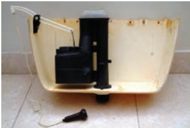
شکل ۳-۲۰۷- نصب پمپ تخلیه درون مخزن فشار
