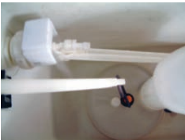
شکل ۲۲۴-۳- بر شدن مخزن فشاری
