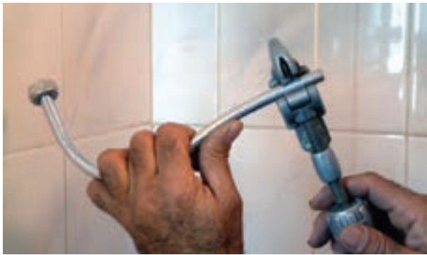
شکل ۲۲۲-۳- بریدن لوله‌ی پیسوار به وسیله‌ی لوله‌بر
