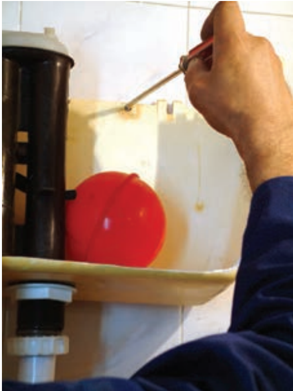
شکل ۲۱۳-۳- نصب مخزن فشاری به دیوار
