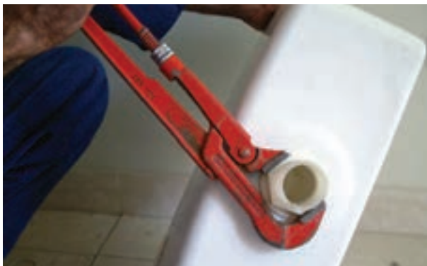
شکل ۳-۲۰۸- سفت کردن مهره‌ی پمپ تخلیه
