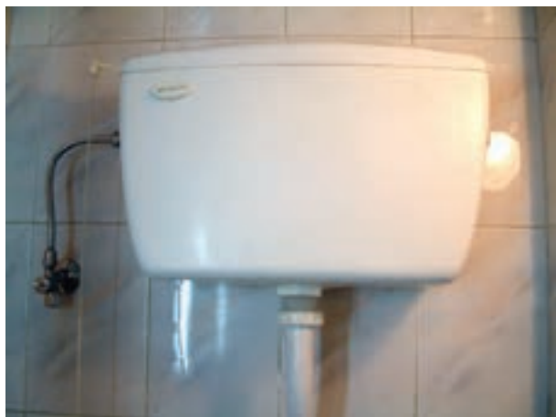
نصب مخزن فشاری
