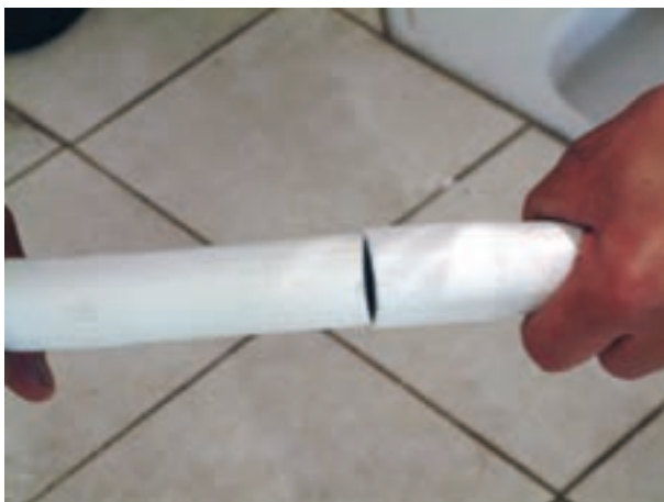
شکل ۲۰۶-۳- جا زدن لوله‌های تخلیه در درون یکدیگر
