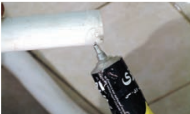
شکل ۲۰۵-۳- زدن چسب به لوله‌های تخلیه
