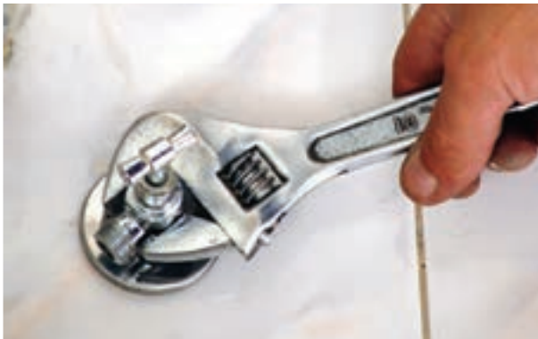
شکل ۲۲۰-۳ سفت کردن شیر پيسوار با آچار فرانسه
