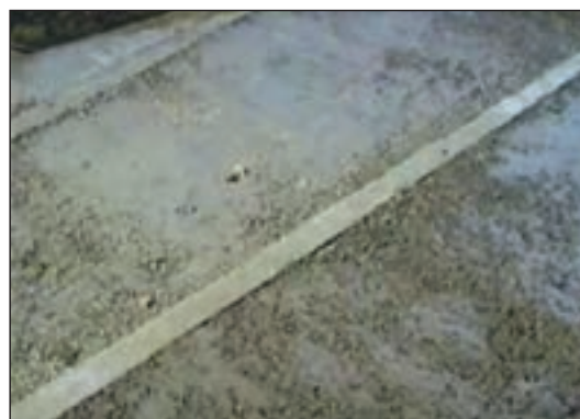
شکل ۲۱-۶ پرکردن فضای بین کرم‌ها با پوکه معدنی
