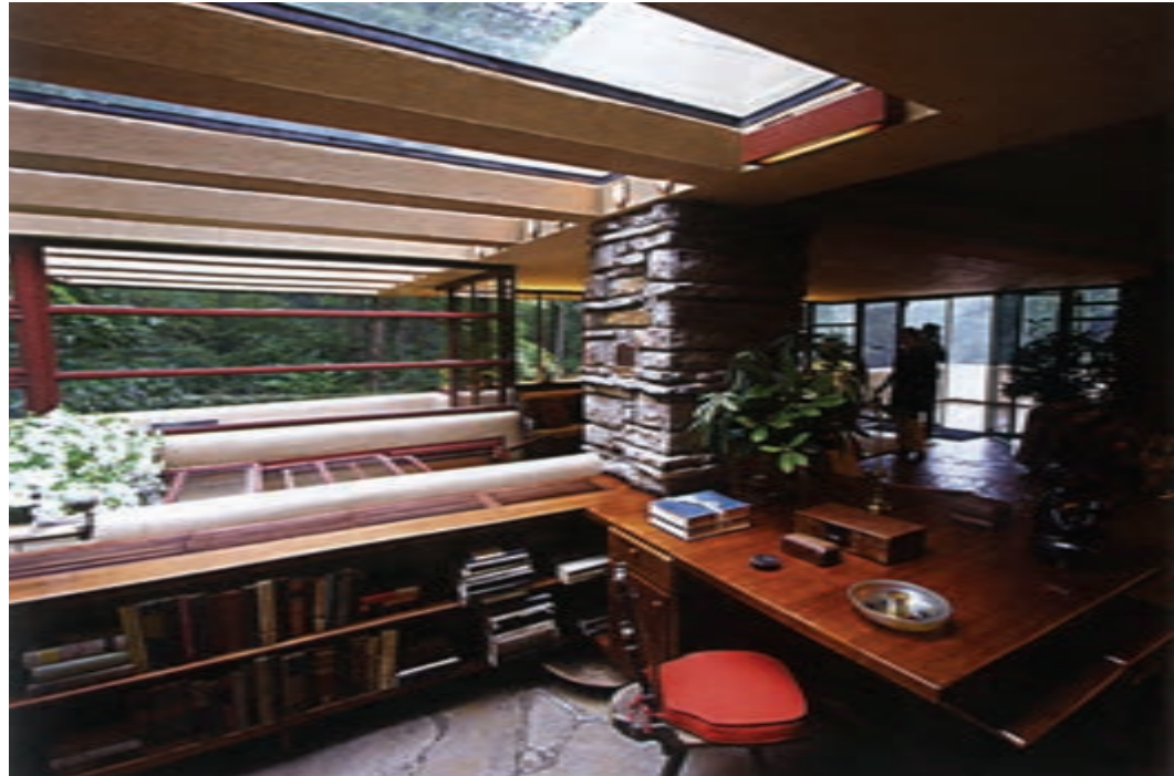
تصویر ۸-۴- نورگیر سقفی در فضای داخلی
