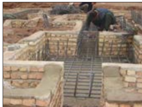
شکل ۱-۸۲ قالب‌بندی آجری در اطراف پی
