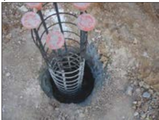
شکل ۱-۷۳ پی چاهی در حال اجرا
