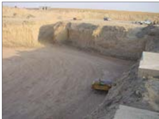
شکل ۸۴-۱ زمین گودبرداری شده
