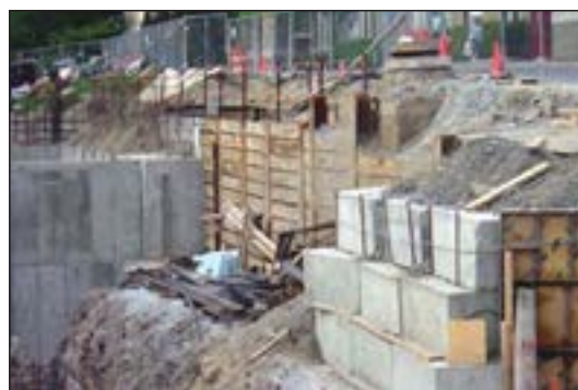
شکل ۹۱-۱ مهاربندی با دیوار مانع چوبی
