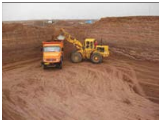
شکل ۸۵-۱ گودبرداری با لودر در زمین نامحدود
