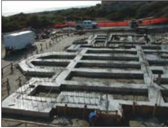
شکل ۱-۵۶ پی بتن مسلح نواری شبکه ای زیرستون
