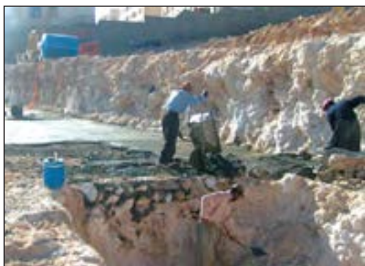
شکل ۸۷-۱ گودبرداری دستی (با بیل و کلنگ)
