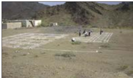
شکل ۸۳-۱ پیاده کردن نقشه روی زمین
