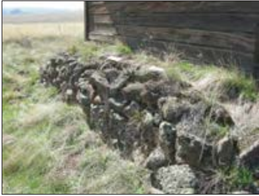
شکل ۱-۳۲ پی سنگی با سنگ لاشه
