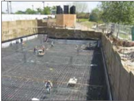
شکل ۱-۶۲ پی بتن مسلح یکپارچه (رادیه ژنرال)
