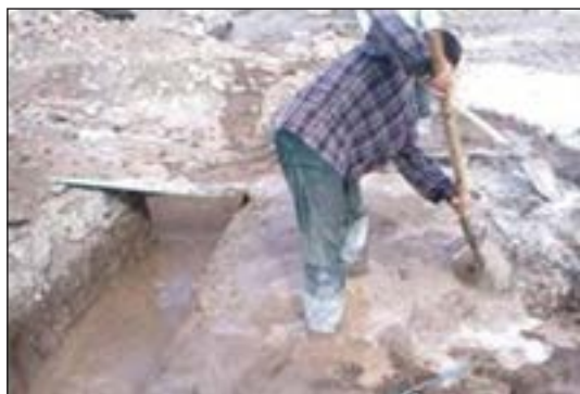
شکل ۱-۳۱ اجرای شفته آهک در فونداسیون
