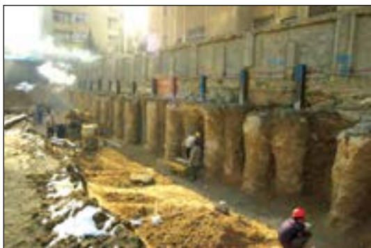
شکل ۸۸-۱ مهاربندی با پشت بند خاکی ستونی
