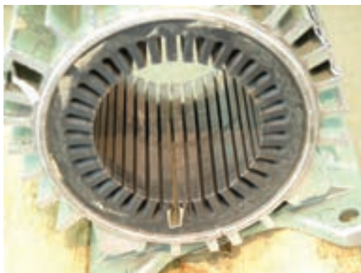
شکل ۲-۳۶ – آزمایش عایق در داخل شیار
