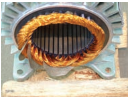
شکل ۲-۳۱- عایق کاری پیشانی کلاف‌ها
