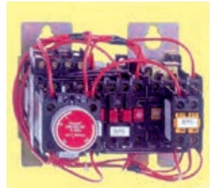
تایمر پنوماتیکی نصب شده روی کنتاکتور (b) شکل ۱-۲۶۳
