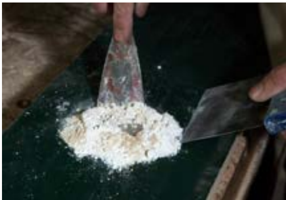
شکل ۱۴-۴. پگه‌نگی کار کردن با کاردک و لیسه.
