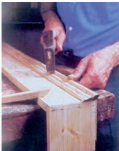
شکل ۱۳-۱۰- نصب زهوار با میخ.
