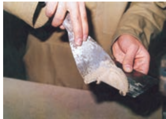
شکل ۸-۴- کاربرد لیسه و کاردک هنگام بتونه کاری.
