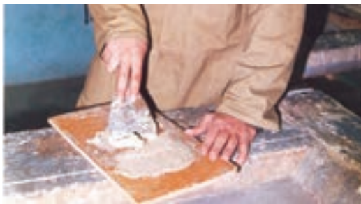
شکل ۹-۴- بتونه روی تخته بتونه تهیه و سافته می شود.
