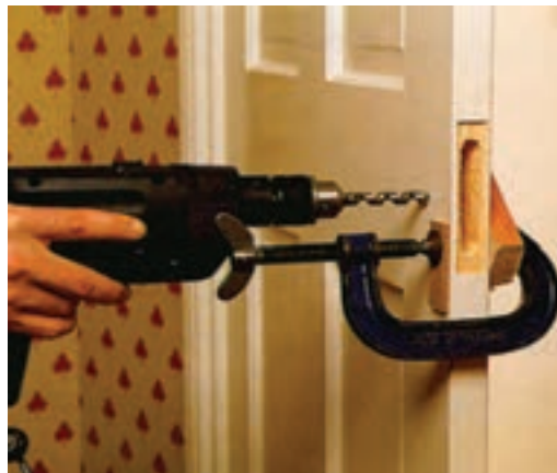
شکل ۱۰-۴۸- سوراخ‌کاری ممل پلاک و دستگیره‌ی قفل.
