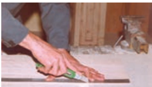
شکل ۵-۲۹- برش (روکش با کاتر)
