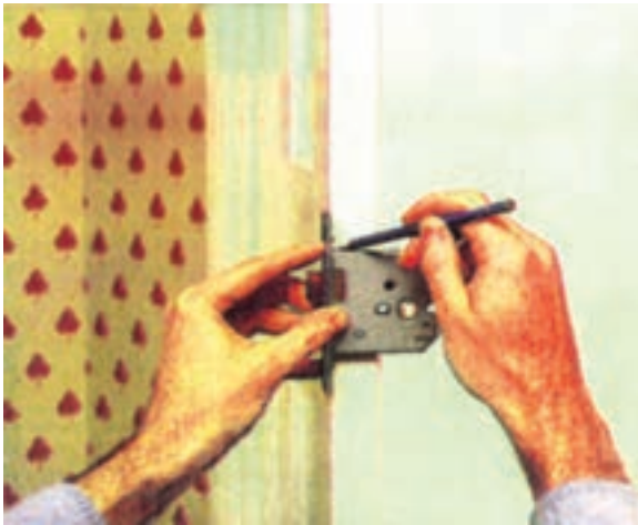
شکل ۱۰-۴۴-۱- فلکشی ممل قفل (روی نر کار).
