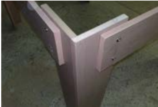
شکل ۱۲-۱۶- اتصال پایه به قید توسط پیچ فیکس.
