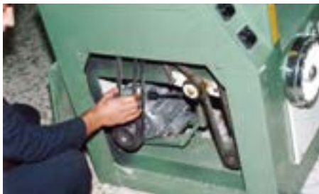
شکل ۲۶-۷. کنترل سفتی تسمه‌ی انتقال نیرو.
