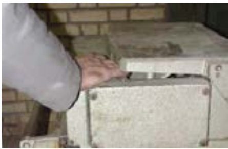
شکل ۸-۲- مراقبت به هنگام بازکردن درپوش.
