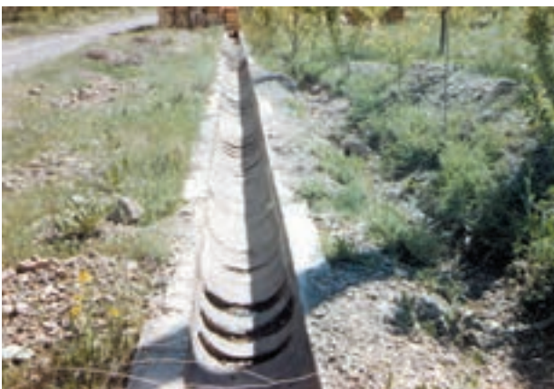
شکل ۲-۲- کانال با مقطع دوزنقه‌ای
