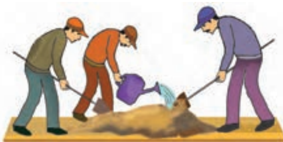
شکل ۳-۷- سرن‌کردن ماسه و مخلوط کردن ملات
