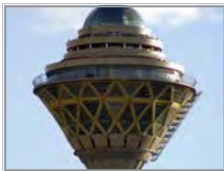
شکل ۱- سازه فلزی برج میلاد
