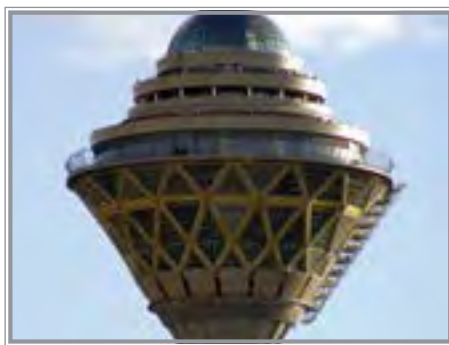
شکل ۱- سازه فلزی برج میلاد
