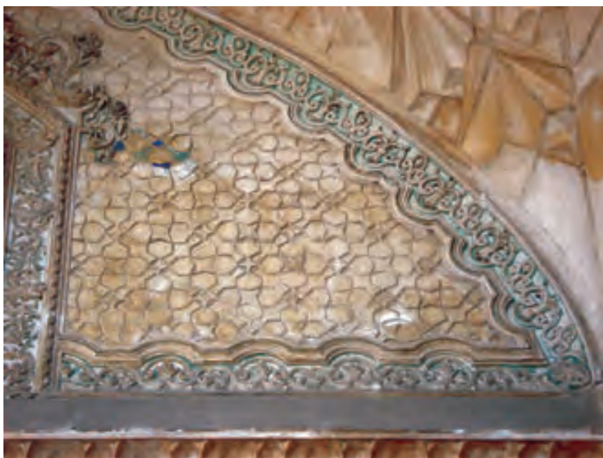
شکل ۲-۲۳- نقش موج و سیلی، گچ‌بری بخشی از دیوار خارجی آرامگاه آقا - تهران
