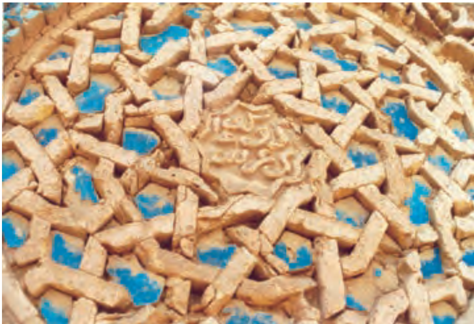
شکل ۲-۷- نقوش هندسی در آجرکاری مسجد ملک زوزن - خاف - ۶۰۰ ه.ق
