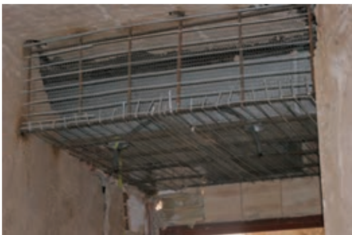
تصویر ۱۸ – اجزای سقف کاذب با استفاده از رابیتس
