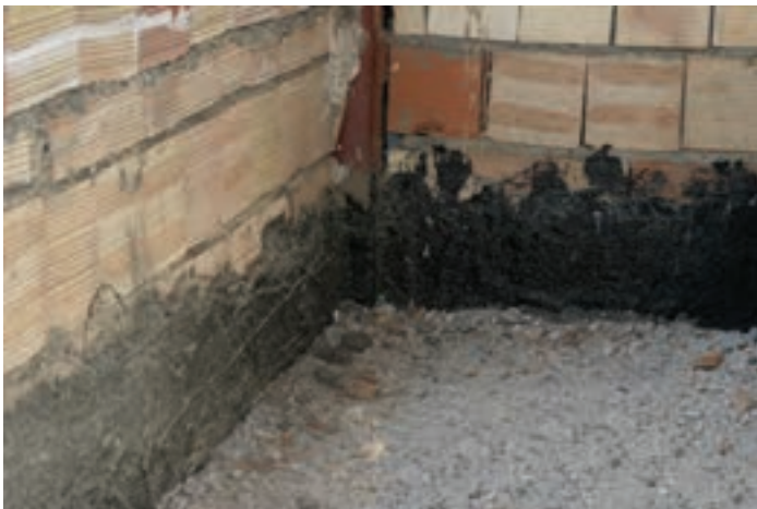
تصویر ۱۶ - عایق‌کاری کف سرویس بهداشتی
