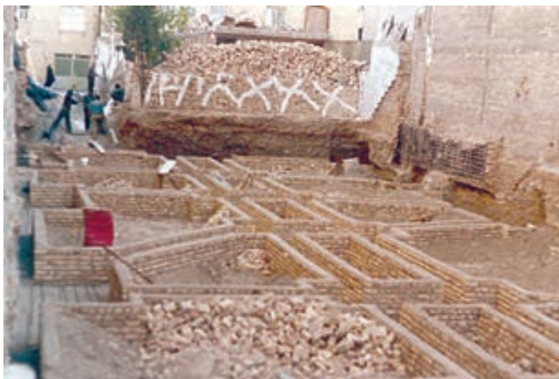
تصویر ۵ - قالب بندی آجری بی ساختمان
