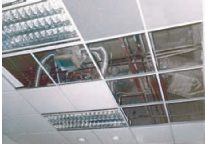
تصویر ۲۰ - زیر سازی سقف کاذب
