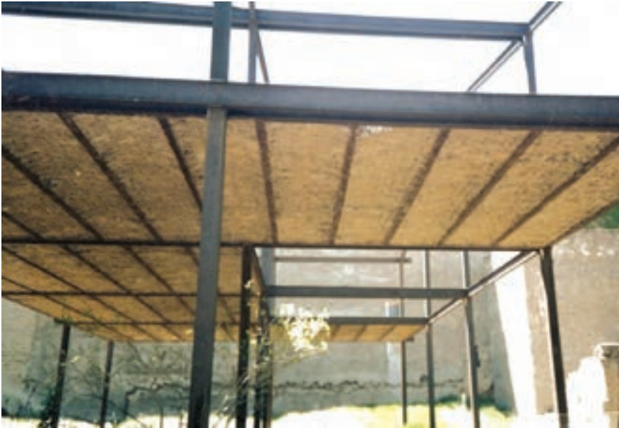
تصویر ۱۰ - تیرریزی سقف طاق ضربی
