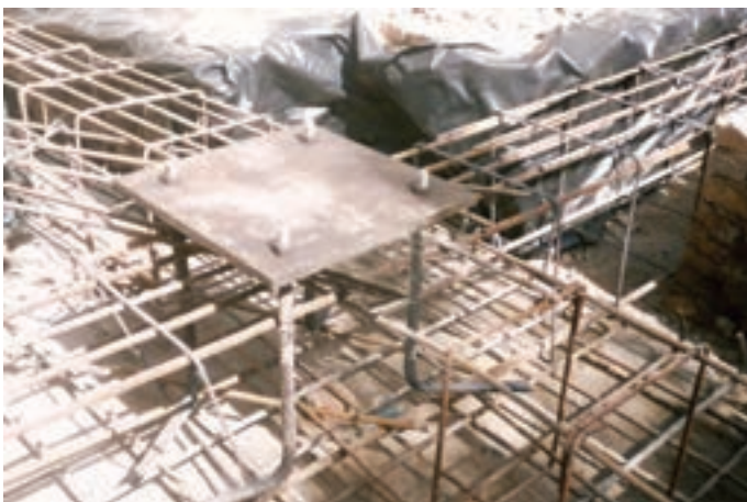
تصویر ۸ - چگونگی اتصال صفحه‌ی بیس پلیت و درگیر شدن بولت‌ها با میل‌گردهای شناژ و پی
