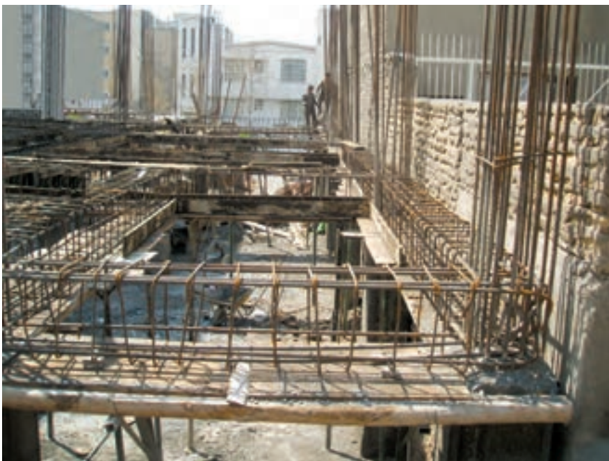
تصویر ۱۲ - نحوه‌ی قرارگیری آرماتورهای کلاف‌های بتنی
