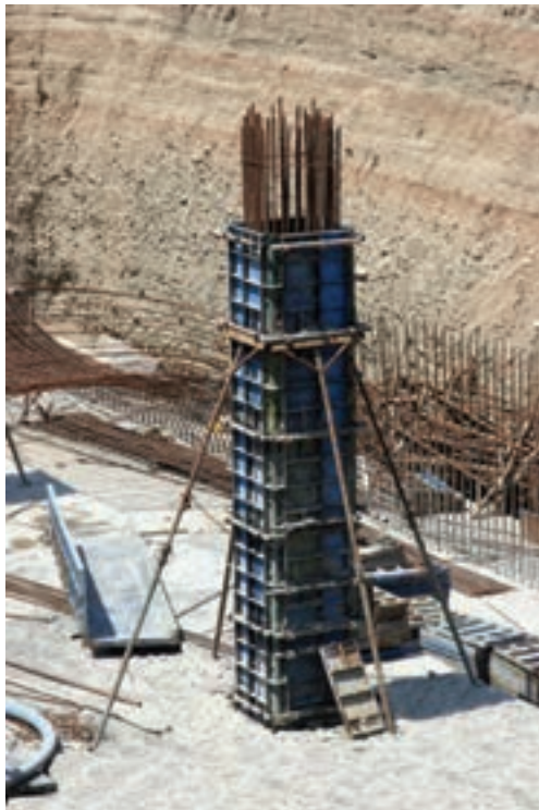
تصویر ۴ - قالب‌بندی فلزی ستون
