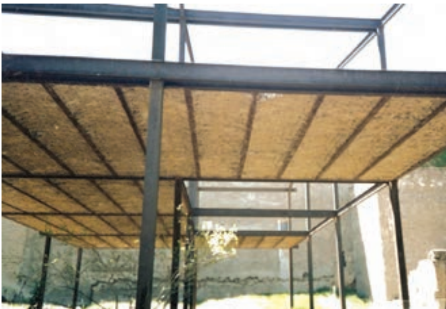
تصویر ۱۰ - تیرریزی سقف طاق ضربی
