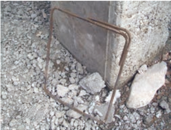
تصویر ۷ - نمونه‌ی یک خاموت
