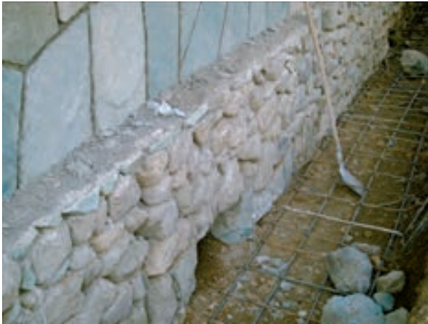
تصویر ۱- پی و دیوار سنگی
