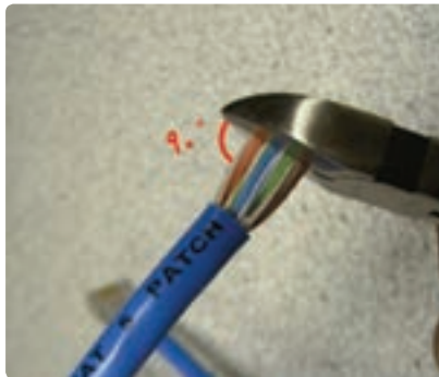
شکل ۴۵-۴- برش سیم‌های کابل شبکه
