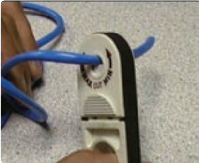
شکل ۴۴-۴- روکش برداری از کابل شبکه
