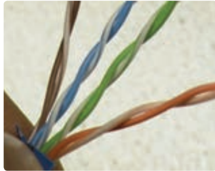
شکل ۴۴-۴- روکش برداری از کابل شبکه
