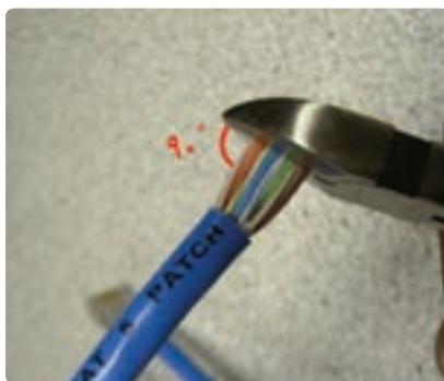
شکل ۴۵-۴- برش سیم‌های کابل شبکه
