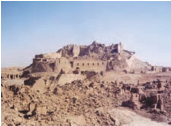
(ب) ارگ بم بعد از زلزله
