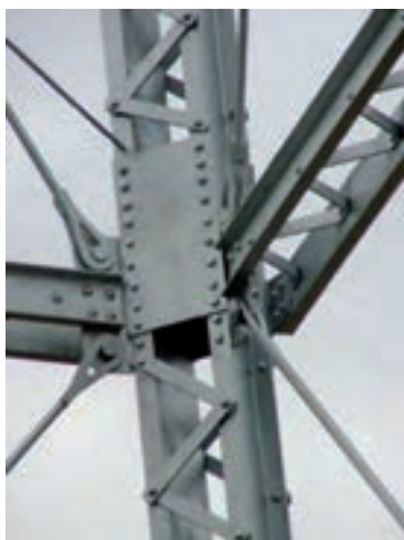
شکل ۳-۱ کاربرد پیچ اتصال
