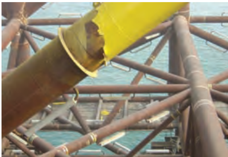
شکل ۷-۲۸- سکوی دریایی که آندهای آلومینیومی جهت حفاظت کاتدی به آن متصل شده است.
