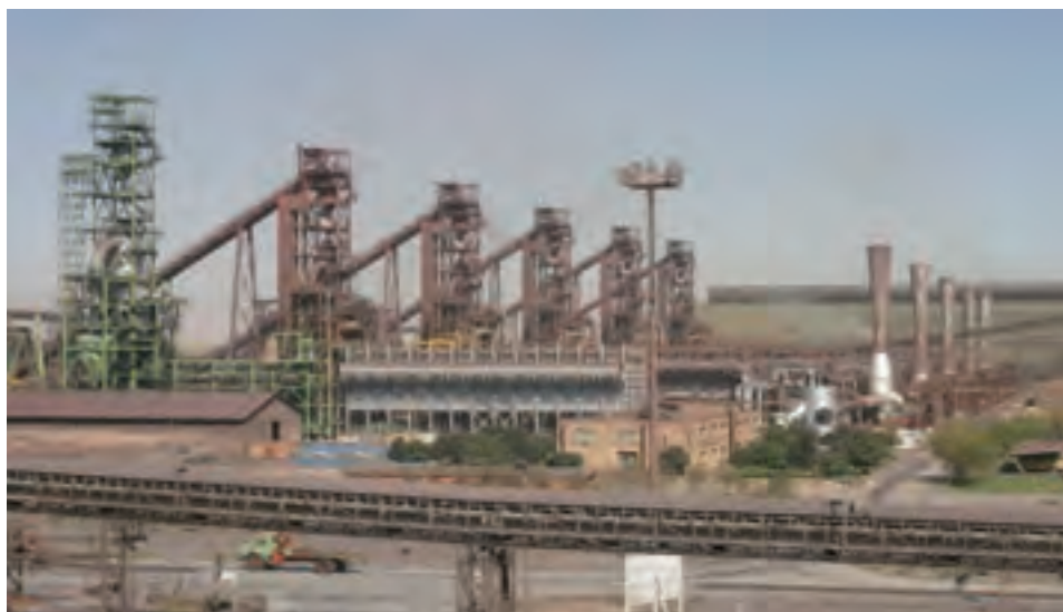
شکل ۱۰-۲- نمایی از کوره‌های احیاء مستقیم مجتمع فولاد مبارکه اصفهان
