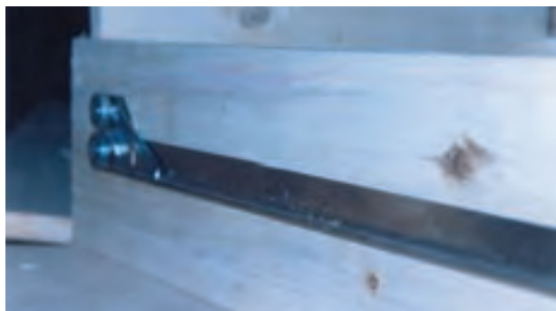
شکل ۳۰- نصب ریل روی جعبه
