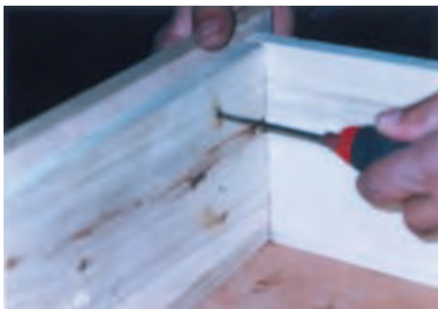
شکل ۳۲- نصب در بیرونی بر روی در داخلی (کاذب) به وسیله ی پیچ
