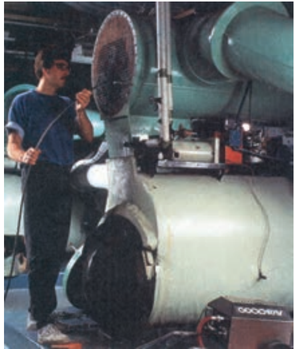
شکل ۶-۴ الف) کندانسر پوسته و کوئل ب) کندانسر پوسته و لوله ج) تمیز کردن لوله‌های کندانسر پوسته و لوله د) برس مخصوص تمیز کردن لوله‌های کندانسر
