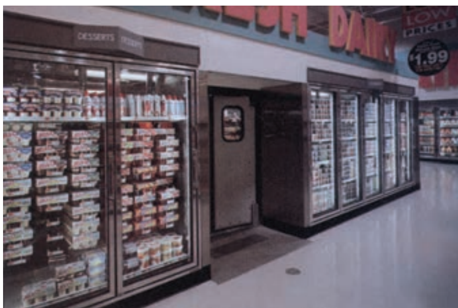
شکل ۱۴-۱۰- در نوع ایستاده امکان برداشت محصول از داخل وجود دارد.
