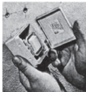
شکل ۵-۳۲- مراحل چگونگی نصب کلید روکار
