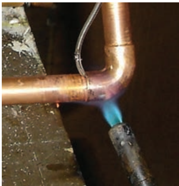
شکل ۱-۵- اتصال لوله‌ی مسی با فیتینگ لحیمی
