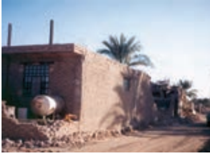
ساختمان نیمه اسکلت با شناژهای افقی و قائم که دچار کم‌ترین آسیب شده است.
