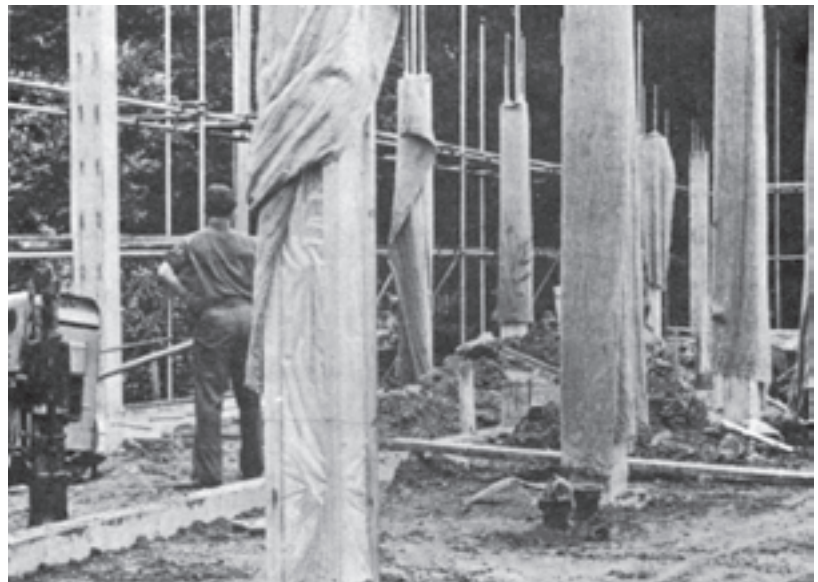
شکل ۶-۳۱- ستون‌های بتنی با نایلون و گونی مرطوب با دقت زیاد عمل آورده می‌شود. دقت کنید که گونی‌ها چگونه از بالای ستون‌ها ریسمان‌پیچی شده‌اند. تمام لبه‌های ستون‌ها با چوب محافظت شده است تا آسیبی به آن‌ها نرسد.
