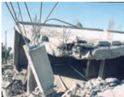
اجرای بتن ریزی نامناسب در محل اتصال موجب شده تا آرماتور به حد جاری شدن نرسد.
