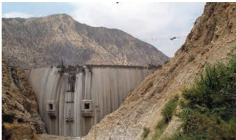
شکل ۱-۲- سد بتنی دو قوسی کارون ۳ که مرتفع‌ترین سد بتنی خاورمیانه است.
