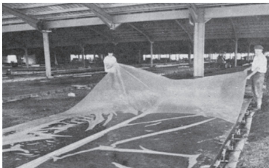
شکل ۳۳-۶- قرار دادن نایلون برای عمل آوردن دال کف
