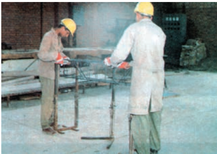
شکل ۱۲-۳- طریقه‌ی مونتاژ آرماتورهای یک پوتر کوچک
