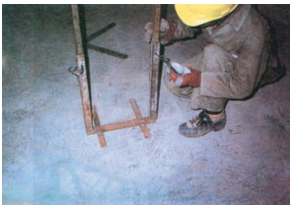
شکل ۹۵-۲- خرک قابل تنظیم برای ارتفاع‌های متفاوت
