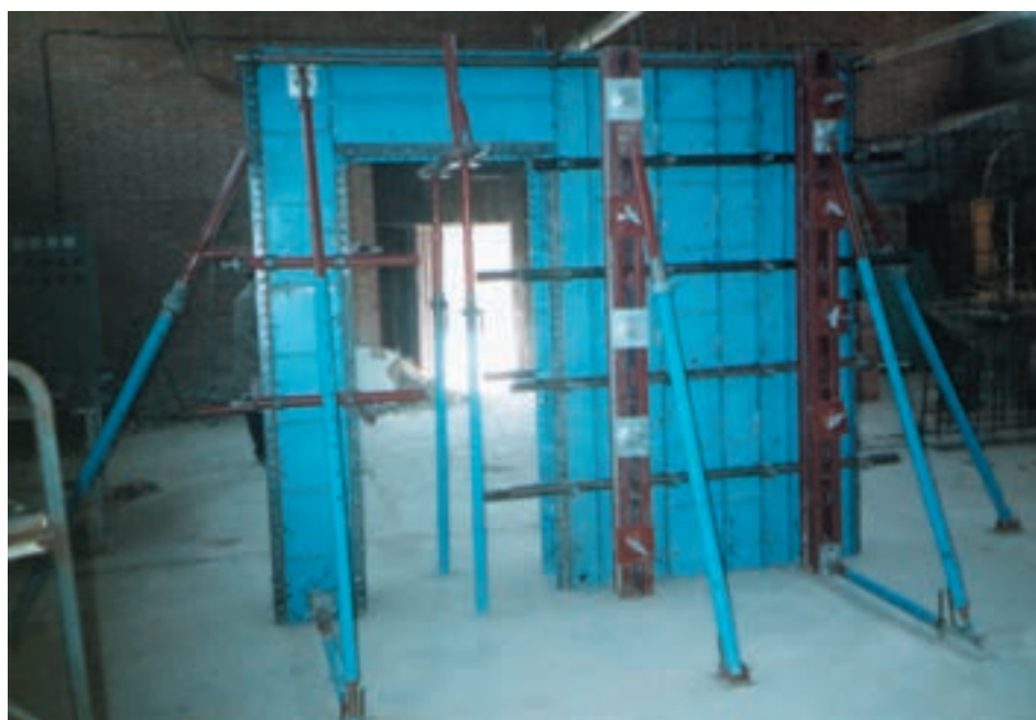
شکل ۸-۲۹ - قالب تکمیل شده ی دیوار و ستون بتنی
