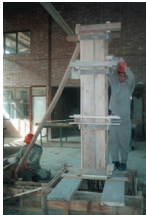
شکل ۲۴-۵ - مهار کردن قالب ستون با استفاده از شاغول
