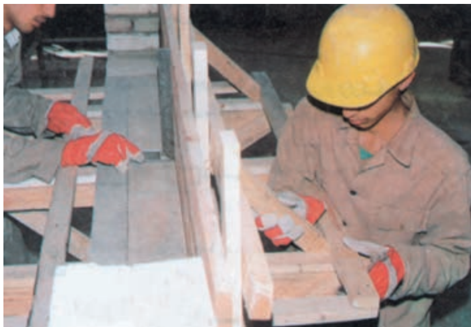
شکل ۱۱-۳ نصب گونه، گونی‌کردن و نصب دستک‌ها
